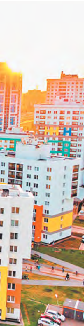
Строящийся жилой район «Академический» в Екатеринбурге
