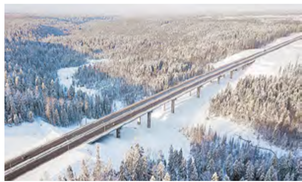
Автодорога А-121 «Сортавала» (Ленинградская область)
