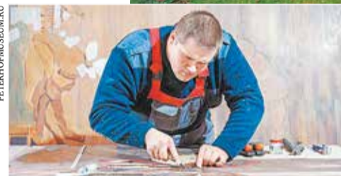
Реставрационные работы в павильоне Кательная горка
