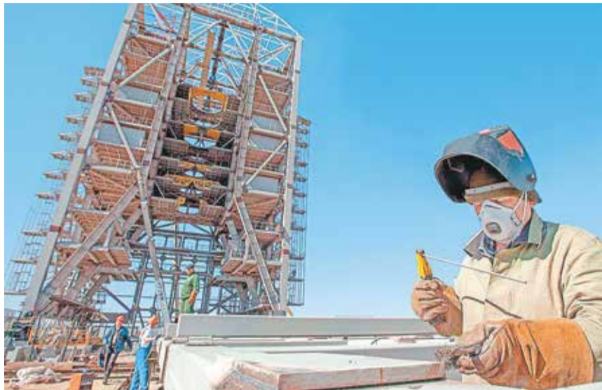
На строительстве космодрома «Восточный»
