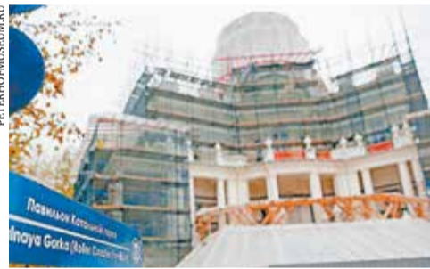
Реставрационные работы в павильоне Кательная горка
