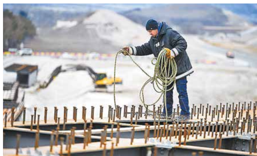
Строительство трассы «Таврида» в Бахчисарайском районе Крыма
