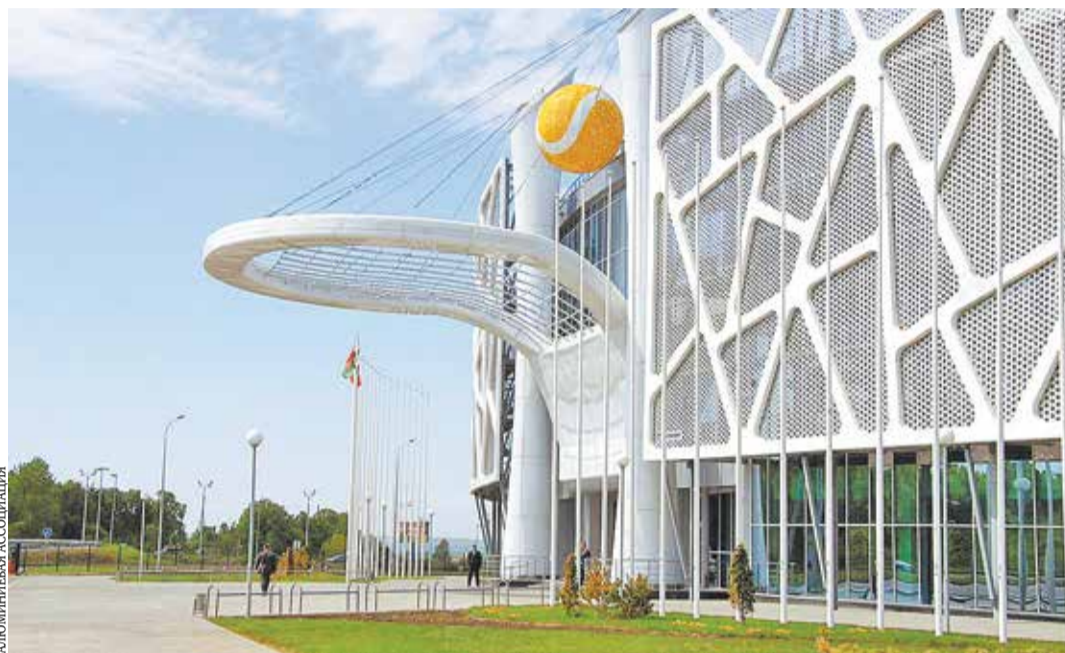
При строительстве Академии тенниса в Казани использовались конструкции из алюминиевых сплавов
