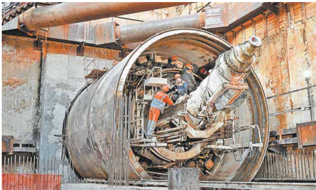
В Москве китайские специалисты и оборудование работают на строительстве Большой кольцевой линии метро
