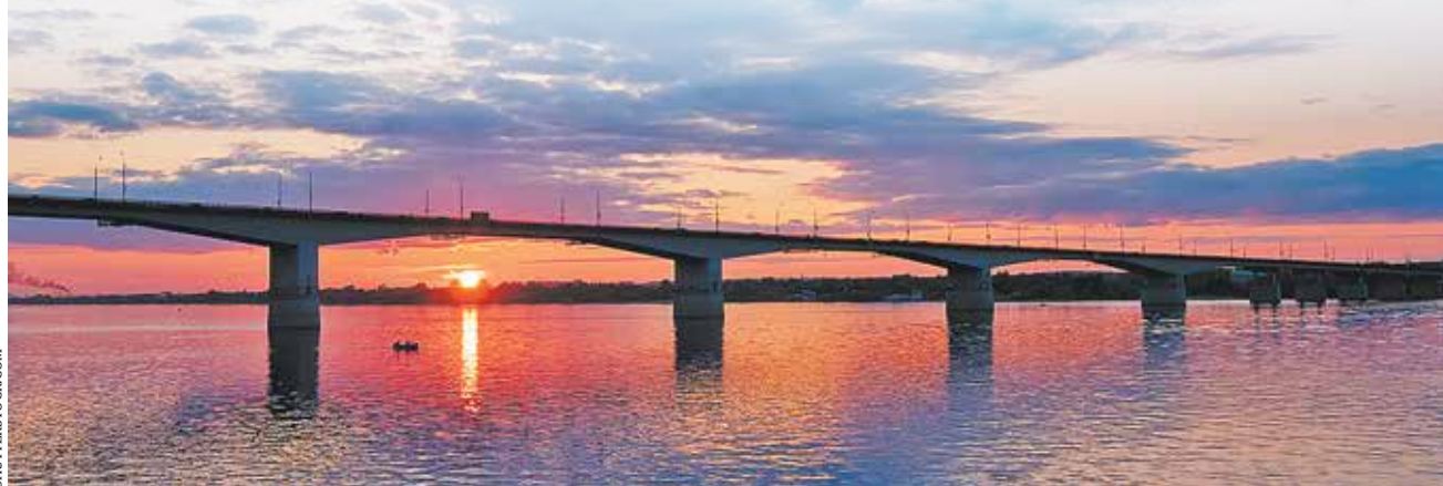
Коммунальный мост через реку Каму в Перми
