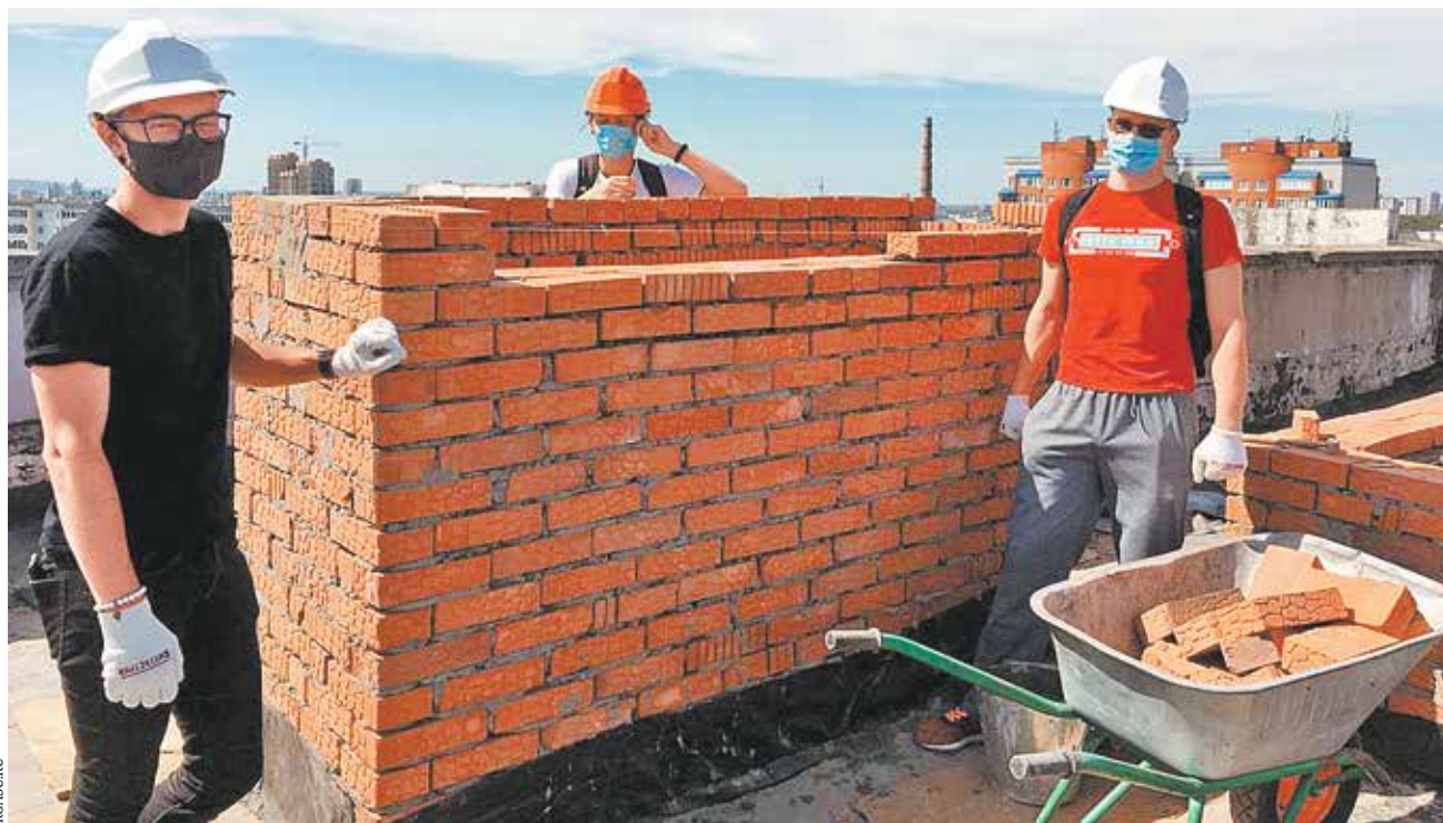
Студенты Казанского государственного архитектурно-строительного университета прошли практику на объекте капитального ремонта (многоквартирный жилой дом)
