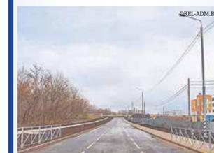
В рамках проекта по строительству трехполосной дороги на территории микрорайона «Зареченский» выполнены работы по устройству проезжей части и дождевой канализации. Также произведена установка дорожных знаков и элементов уличного освещения. Кроме того, обустроены тротуары, нанесена разметка и организован пешеходный переход.
