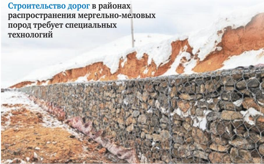
Для укрепления и защиты дорожных насыпей применяются габионные конструкции
