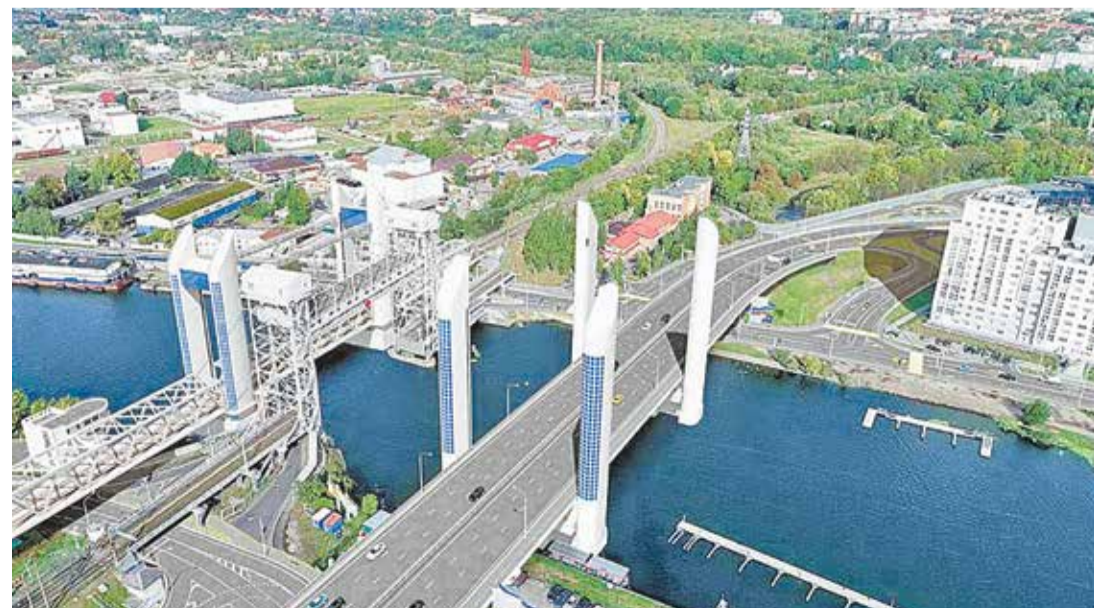
Рядом с историческим двухъярусным мостом (в центре) построят два новых — железнодорожный (слева) и автомобильный
