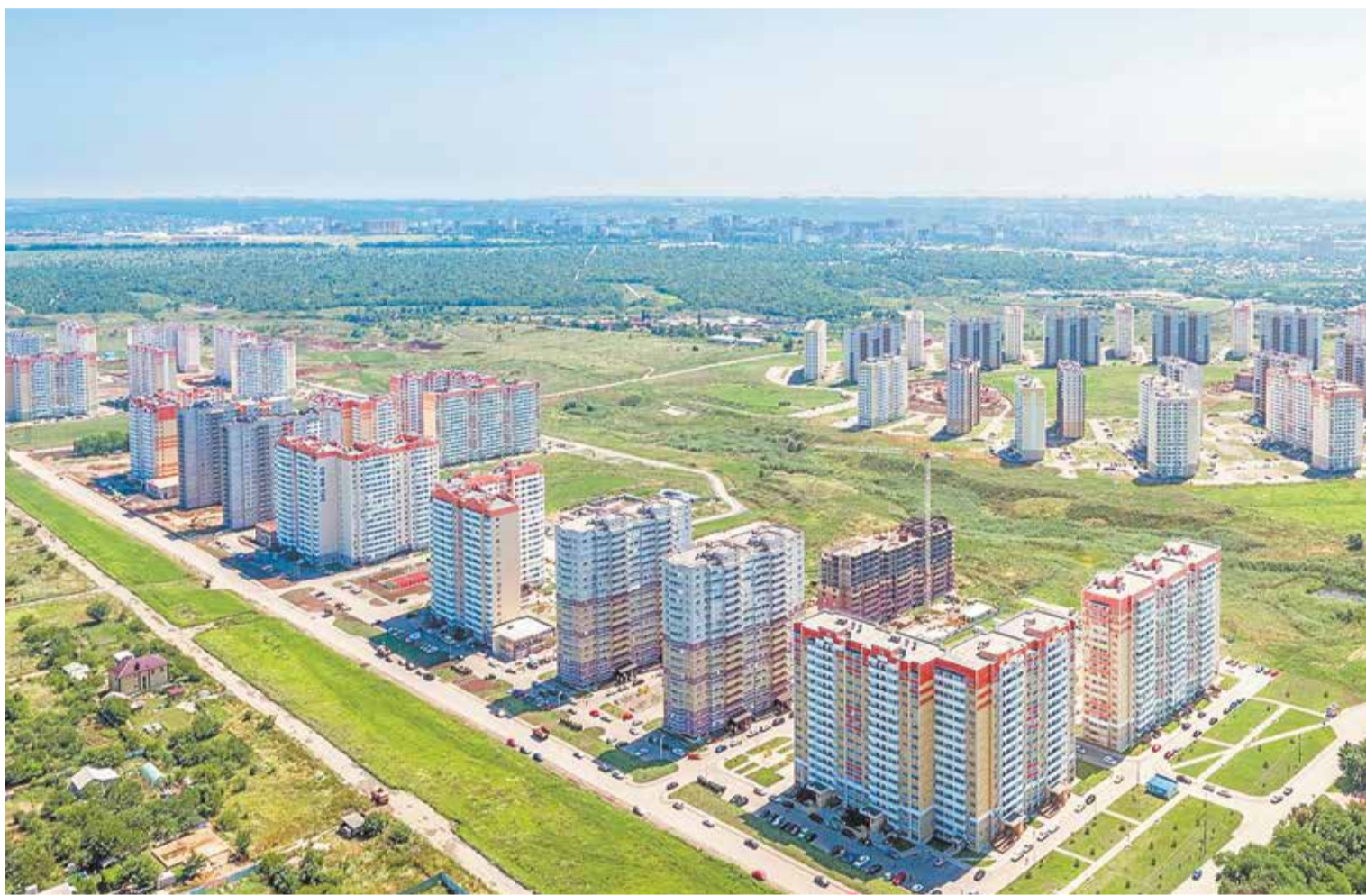
ЖК «Суворовский» — крупнейший по объемам текущего строительства в Ростове-на-Дону, в нем возводятся 13 домов совокупной площадью 231 275 кв. м
