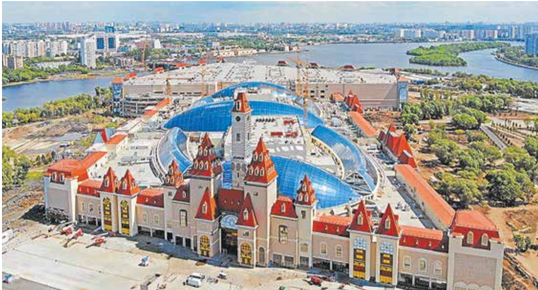
В строящемся парке развлечений «Остров мечты» торговый центр займет 65 тыс. кв. м
