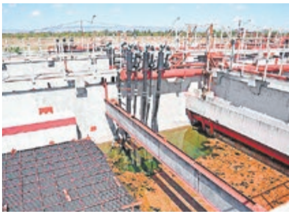
Водоочистные сооружения в Беслане
