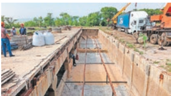
Работы по реконструкции Курсавских очистных сооружений
