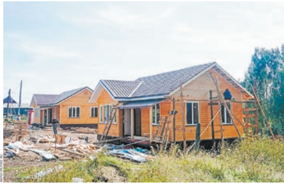
Строительство быстровозводимых частных домов в микрорайоне Березовая Роща в Тулуне Иркутской области
