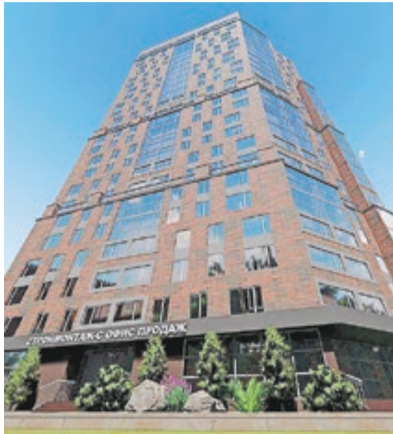
Самое высокое здание, строящееся в Калужской области, — 27-этажный многоквартирный дом в ЖК «Дом по ул. Белинского» (Калуга)
