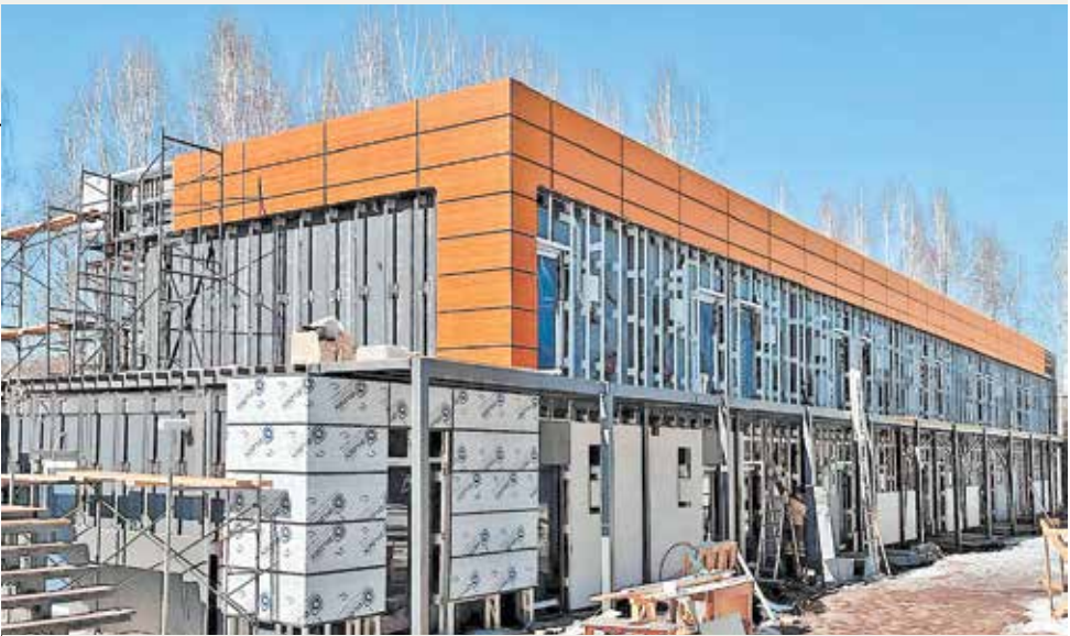
Монтаж фасадных конструкций с алюминиевыми композитными панелями на здании крупнейшего в стране модульного гостиничного комплекса на Алтае
