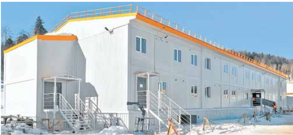
Общежития вахтового поселка в Хабаровском крае собраны из модулей «Хаски» с ограждающими конструкциями из трехслойных сэндвич-панелей с 200-миллиметровым утеплителем
