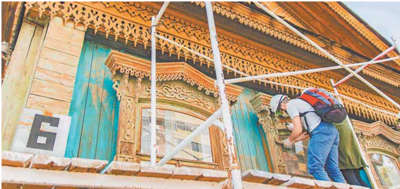
В Екатеринбурге волонтеры начали восстанавливать деревянный дом на улице Чернышевского
