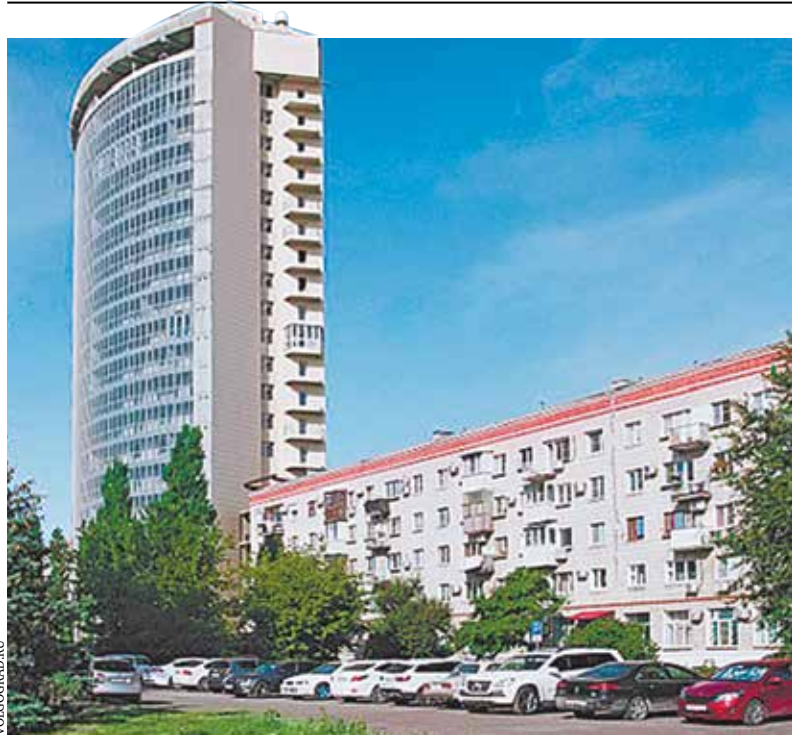
Многоэтажный дом на улице Чуйкова (слева) возводится с 2004 года
