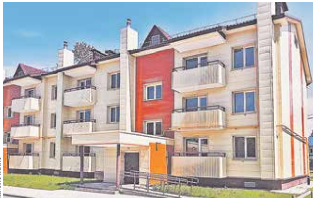
Многоквартирный дом в Южно-Сахалинске, построенный для переселения граждан из аварийного жилья
