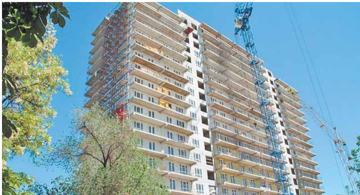
Строящийся дом в ЖК «Династия»
