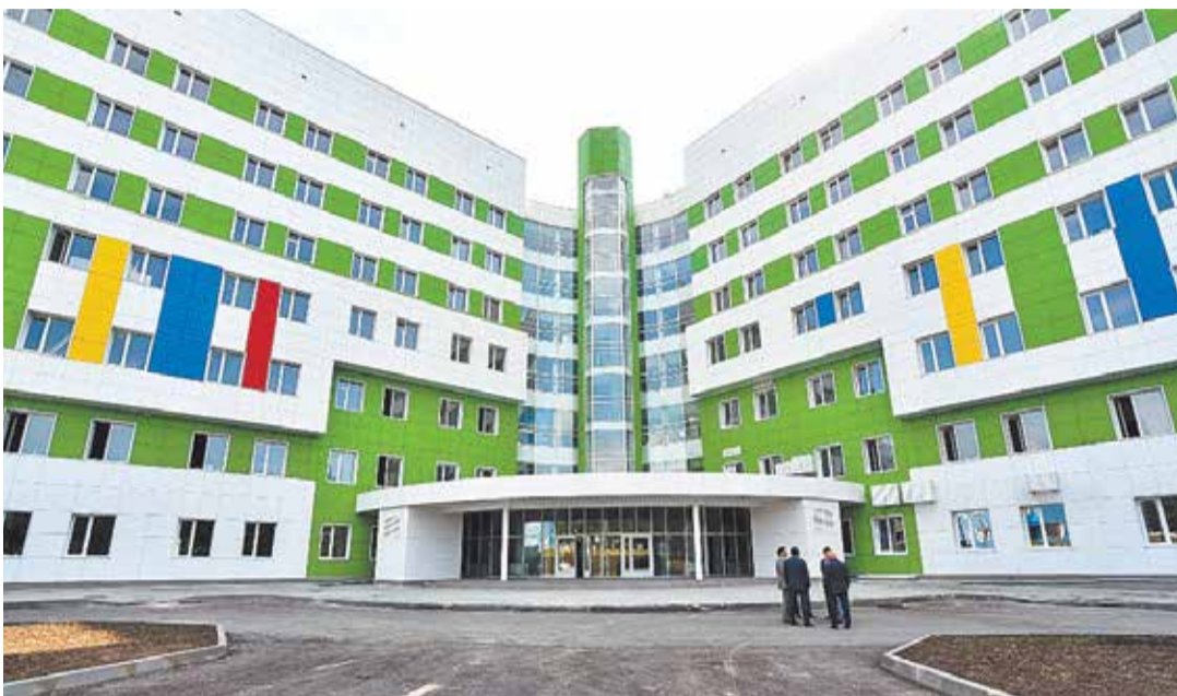
Строительство областного перинатального центра в Новосибирске
