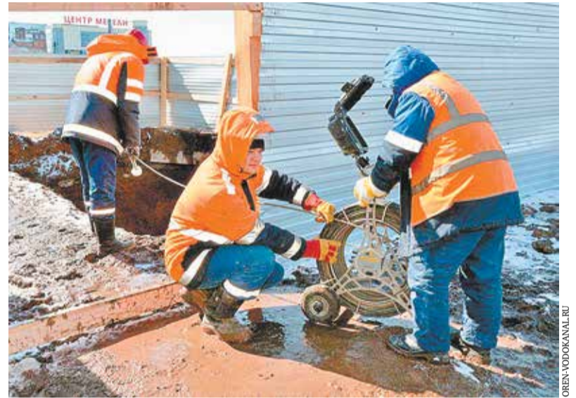
Реконструкция участка самотечного канализационного коллектора (Оренбург)
