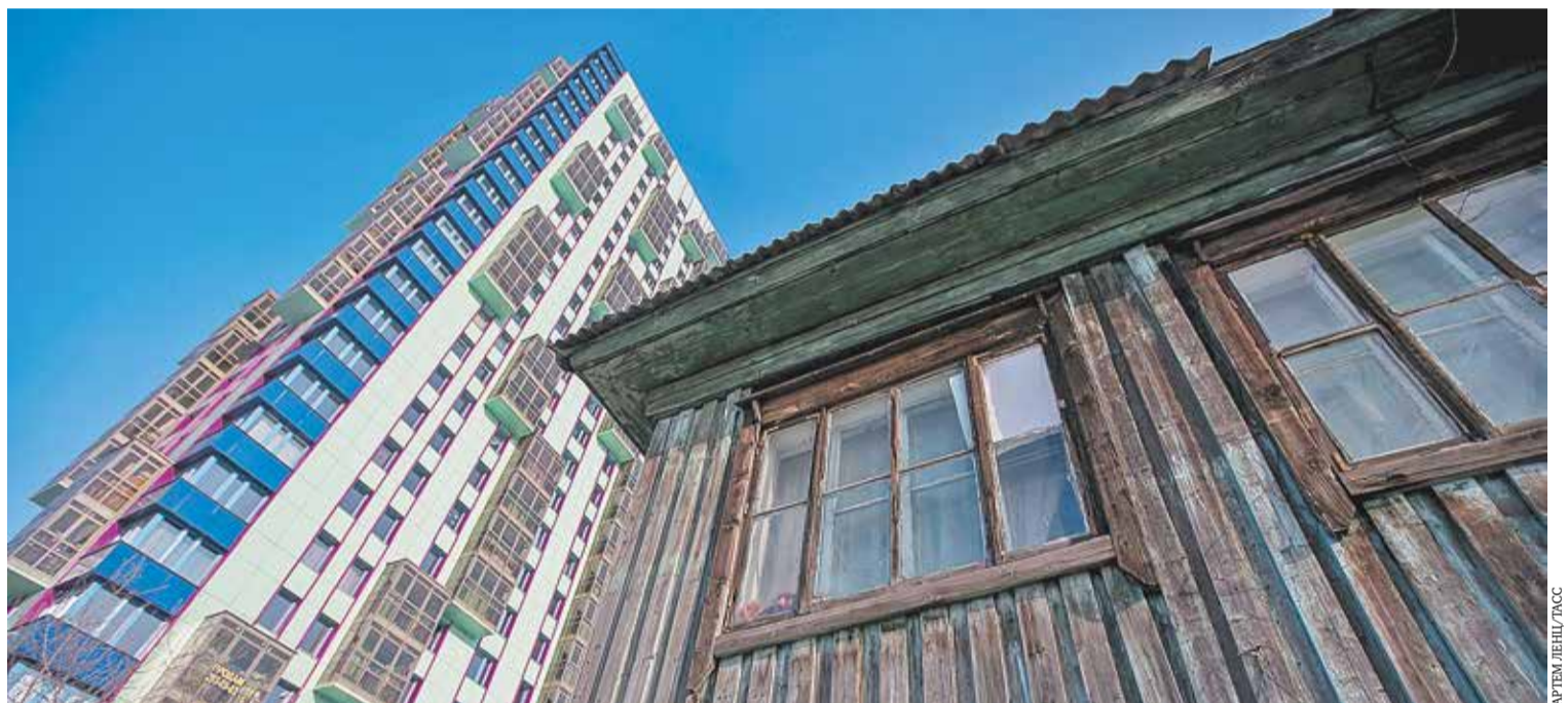
Площадь аварийного жилья в РФ превысила 12 млн кв. м (на 1 января 2018 года). На фото: аварийный многоквартирный дом на улице Ленина в Красноярске (на переднем плане)
