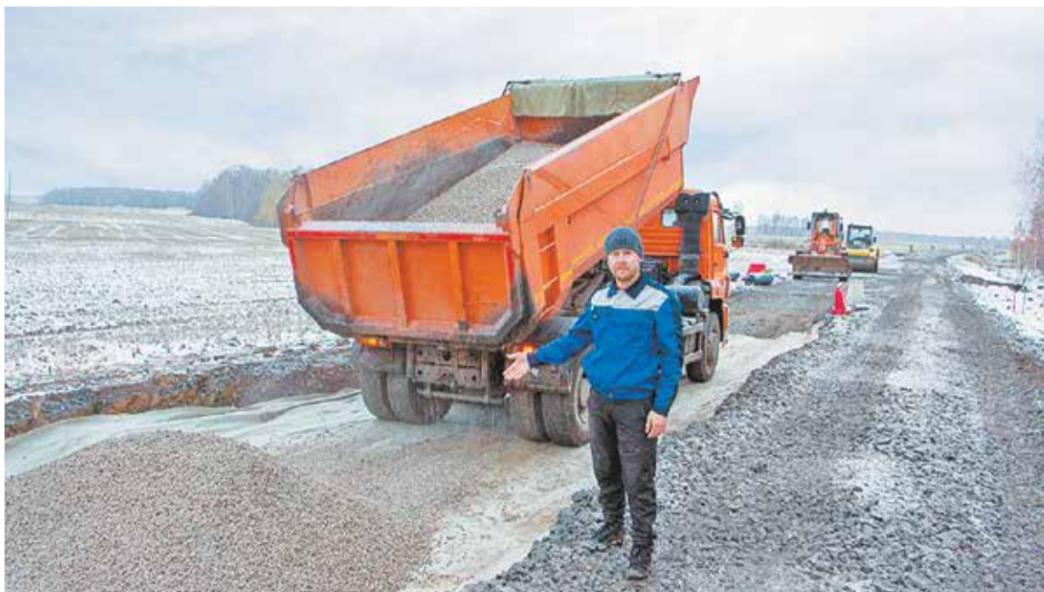
Строительство опытно-экспериментального участка автомобильной дороги «Бескозобово—Евсино—Ламенский» (Тюменская область) с устройством морозозащитного слоя из гранулированного теплоизоляционного материала «ДиатомИК»
