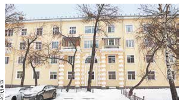
Дом на улице Степана Разина в Екатеринбурге, здесь был проведен капитальный ремонт крыши, фасада и подвального помещения
