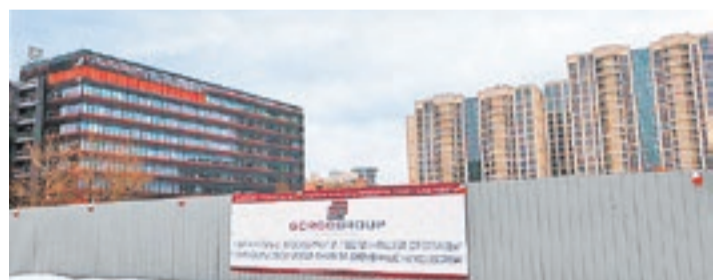
Строительная площадка на Звенигородском шоссе, где будет работать компания из Петербурга
