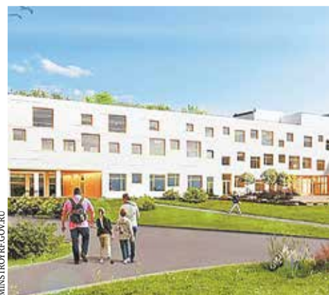
Эта школа в Белгородской области строится по программе «Стимул» национального проекта «Жилье и городская среда»
