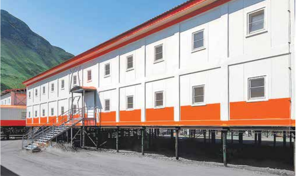
В вахтовом поселке в районе золоторудного месторождения в Якутии команда ГК «Авеста Модуль Инжиниринг» построила три модульных общежития общей площадью 3,5 тыс. кв. м для 300 сотрудников компании-недропользователя
