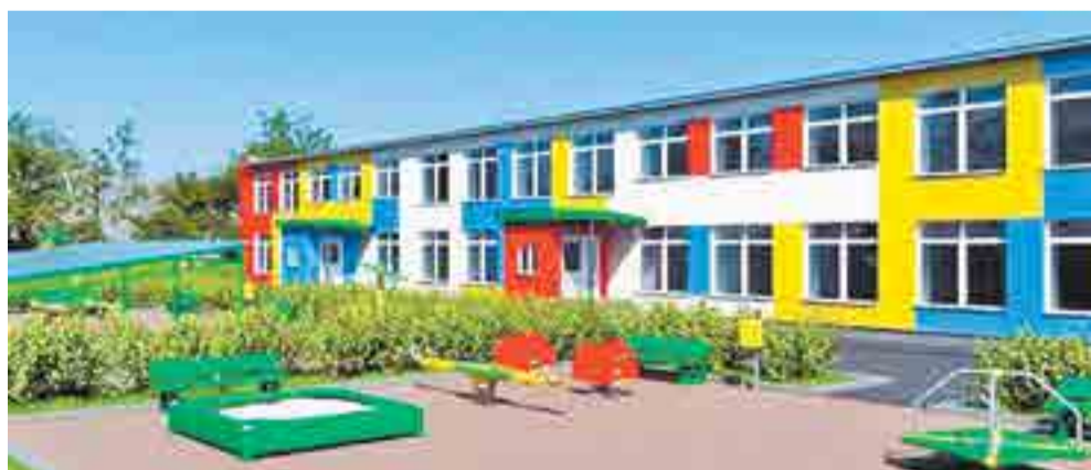
Здание детского сада «Ежик» в Ульяновске после ремонта
