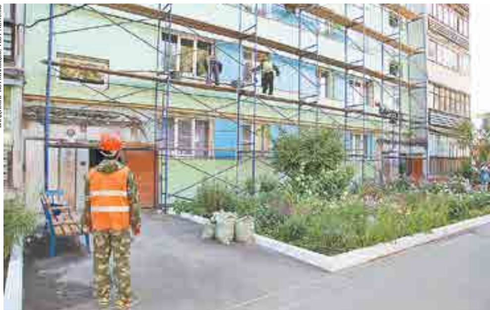
Ремонт дома в Калуге
