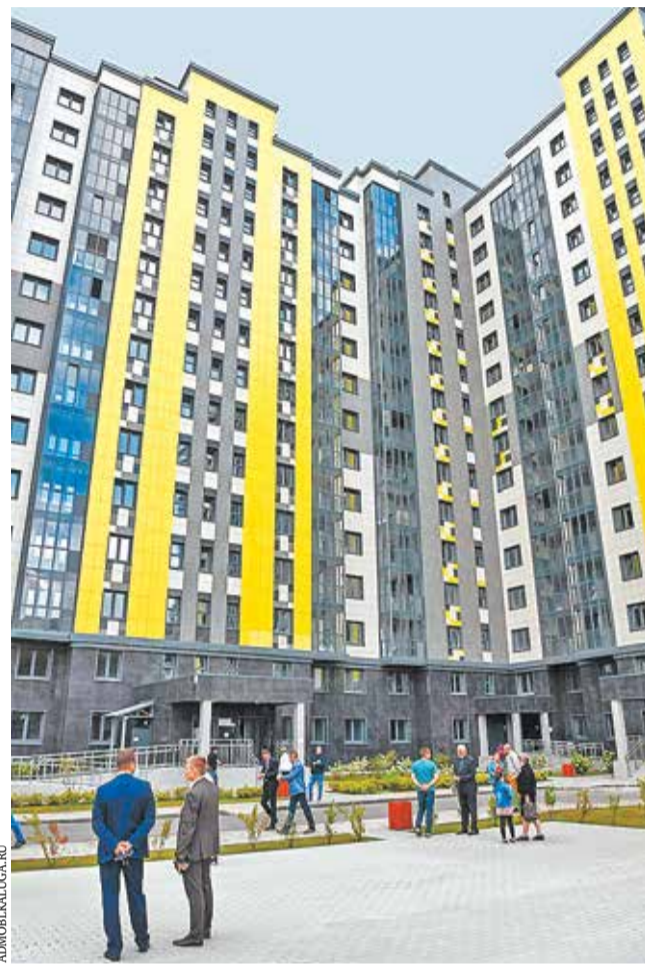
Дом на улице Курчатова в Обнинске (Калужская область), где были приобретены квартиры для переселения граждан из аварийного жилищного фонда
